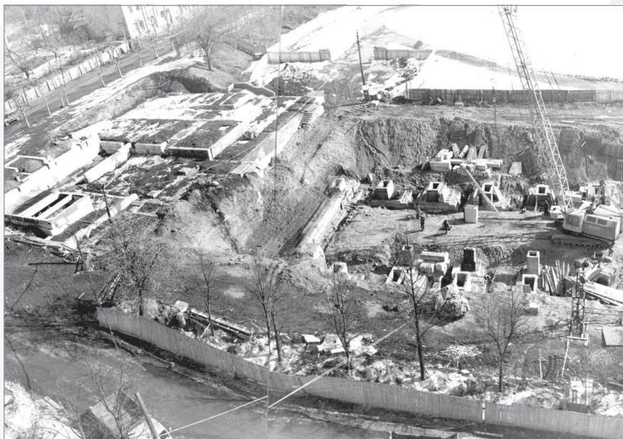
Начало строительства бассейна и стадиона «Динамо» в Ижевске. 1984-1985 гг.
